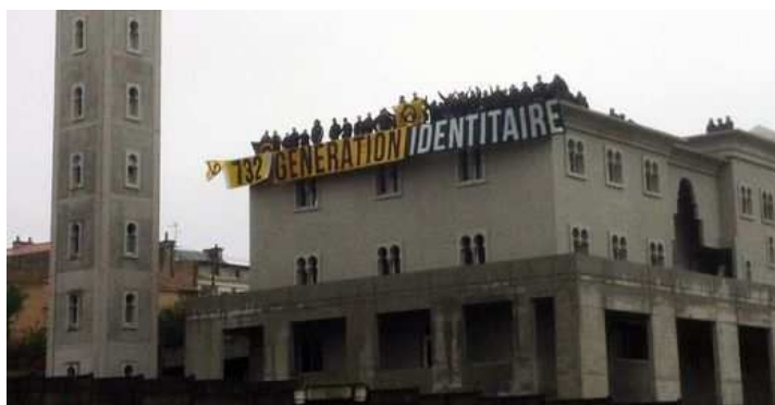
Poitiers : occupation du chantier de la mosquée par des militants nationalistes (octobre 2012)
